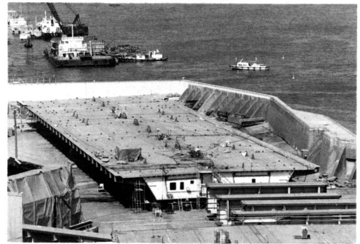
図 5 補剛桁の仮組立
