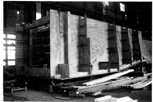
図 4 桁端ケーブル定着ブロックの組立
