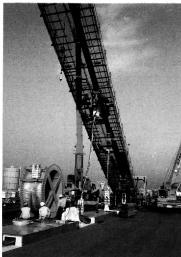
図 24 ハンガーケーブル架設
