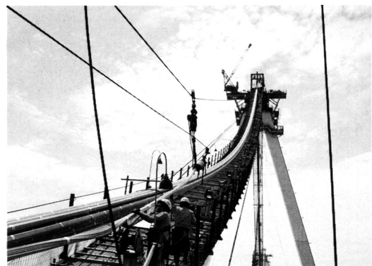
図 16 ストランド架設
